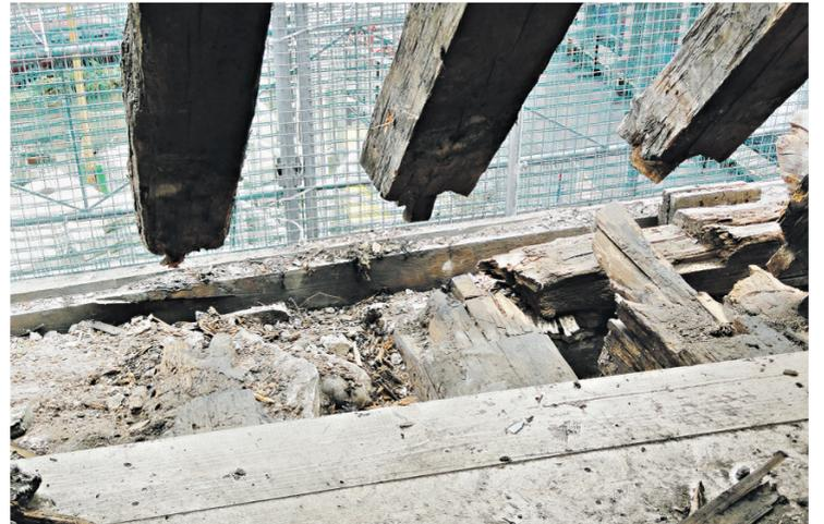
Eine gebrochene und teils verfaulte Holzkonstruktion sorgte für eine statische Instabilität.
