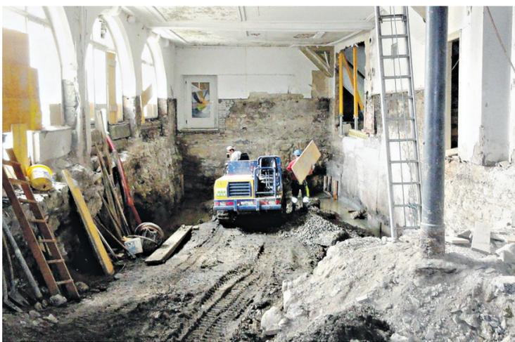
Um die Unterkellerung zu realisieren, musste im Gebäudeinneren der Boden abgesenkt werden.
