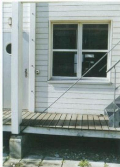
Tür- und Fensteranschlüsse mit Bodenkonstruktion
