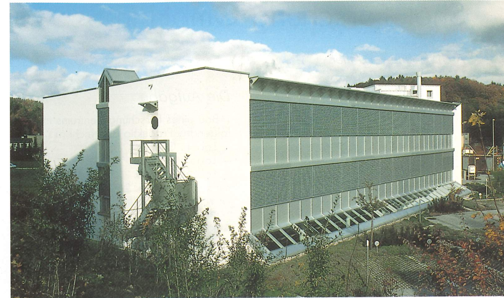
Ansicht von Norden
