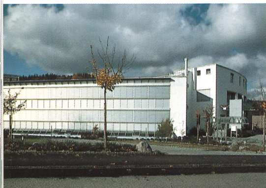
Ansicht von Osten (Haupteingang)
